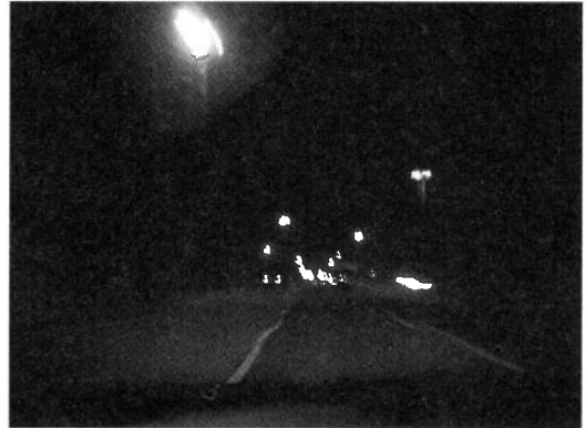
図16 夜の高速道路。照明配置により道路線形をドライバーに認知させる配慮はされていない。
