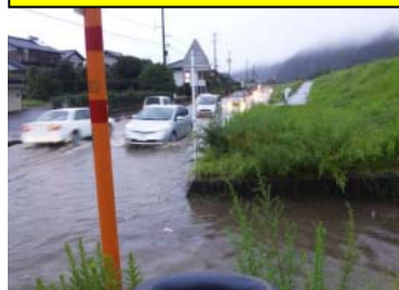
国道21号の冠水状況
